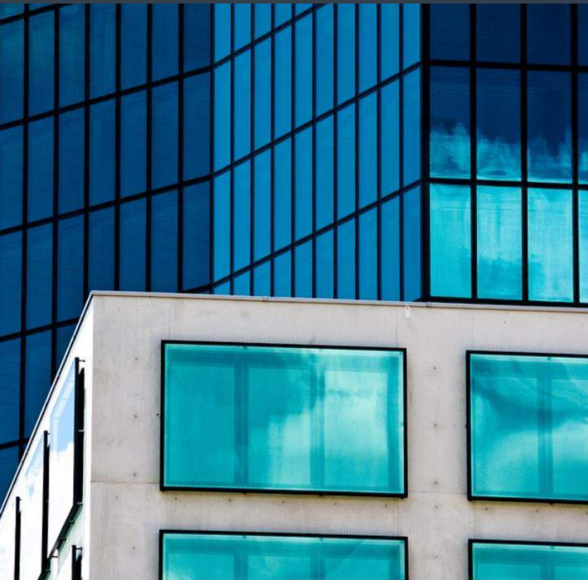
Oberflächen von Gebäuden
